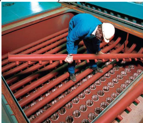
Slika A-6. Postavljanje mlaznica za čišćenje vreća stlačenim zrakom u jednoj komori vrećastog filtra.
